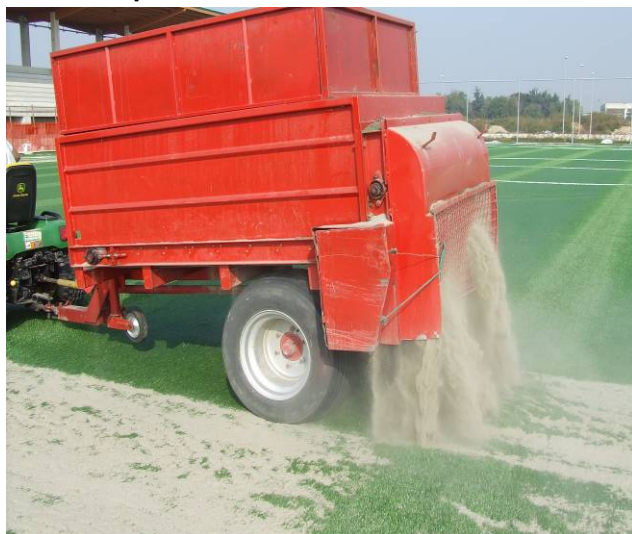
Operazione di sabbiatura
