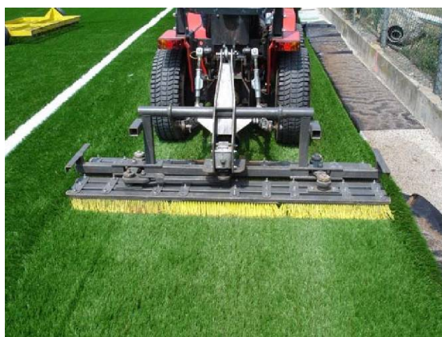
Operazione di spazzolatura
