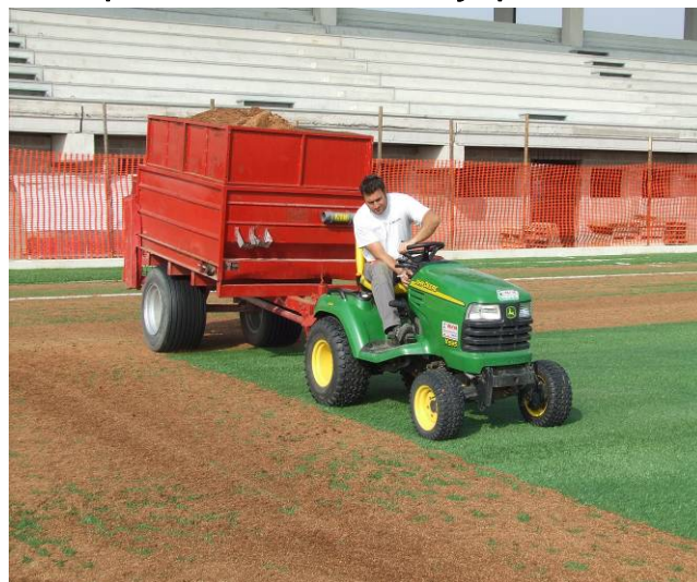
Operazione di stesura di Infillpro Geo
