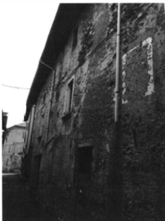
Foto n.2 Facciata esterna dell'edificio su Vicolo San Lorenzo
