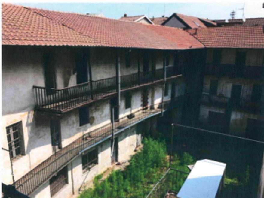
Foto n.3 Facciata interna dell'edificio
