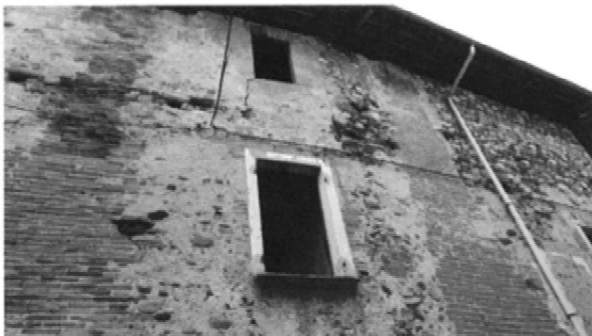
Foto n.1 Facciata esterna dell'edificio su Vicolo San Lorenzo
