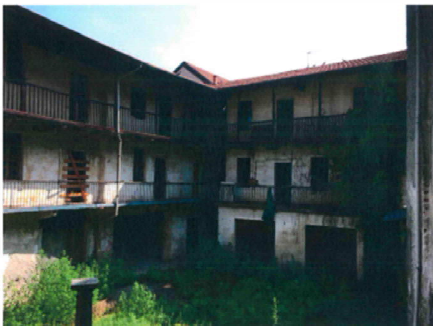
Foto n.4 Facciata interna dell'edificio
