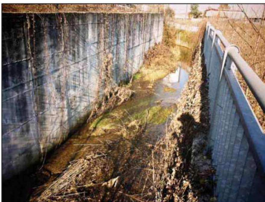
Figura 79 – Tratto del fosso Geola a valle del superamento della SR142 Biellese con argini cementificati ma presenza di depositi e vegetazione terrestre pioniera in alveo.
