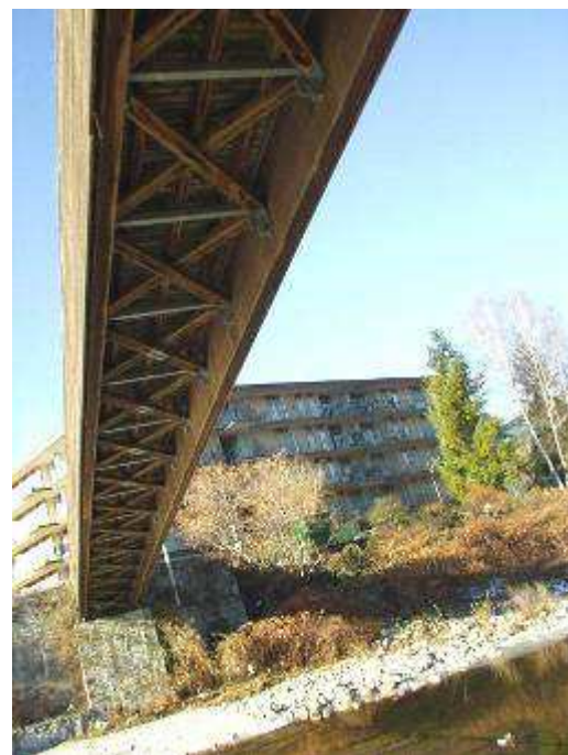
4.1 c) Struttura metallica inferiore di irrigidimento e controventatura, Verbania
