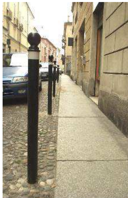
6.3 a) Dissuasori verticali in metallo verniciato con applicato nastro rifrangente Novara
