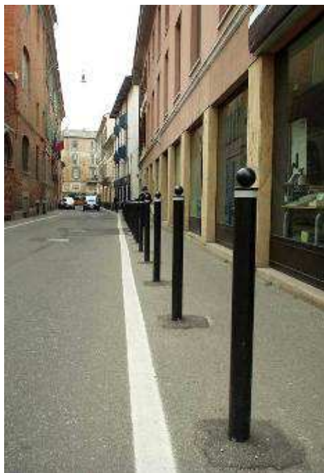
6.3 a) Dissuasori verticali in metallo verniciato con applicato nastro rifrangente Novara
