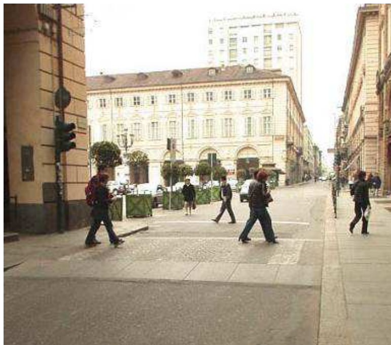
4 a) Attraversamento pedonale su plateau rialzato realizzato in lastre e blocchetti di pietra Piazza S. Carlo, Torino
