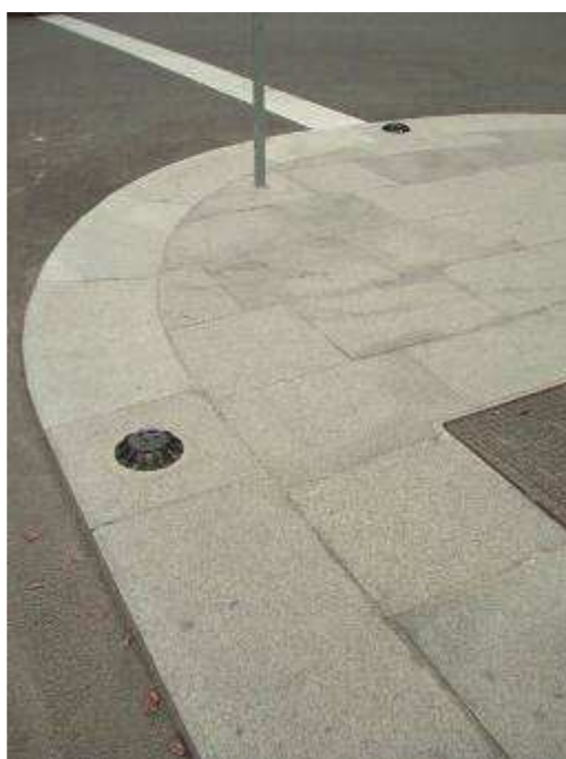
3 b) Spartitraffico con cordolo e pavimentazione in pietra con corpi illuminanti incassati di segnalazione, Torino
