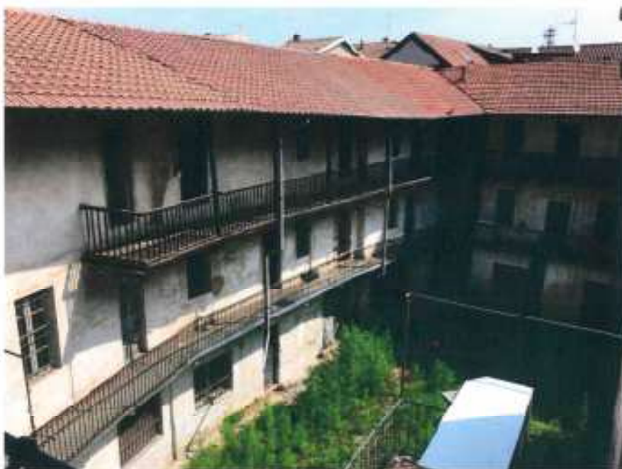
Foto n.3 Facciata interna dell'edificio
