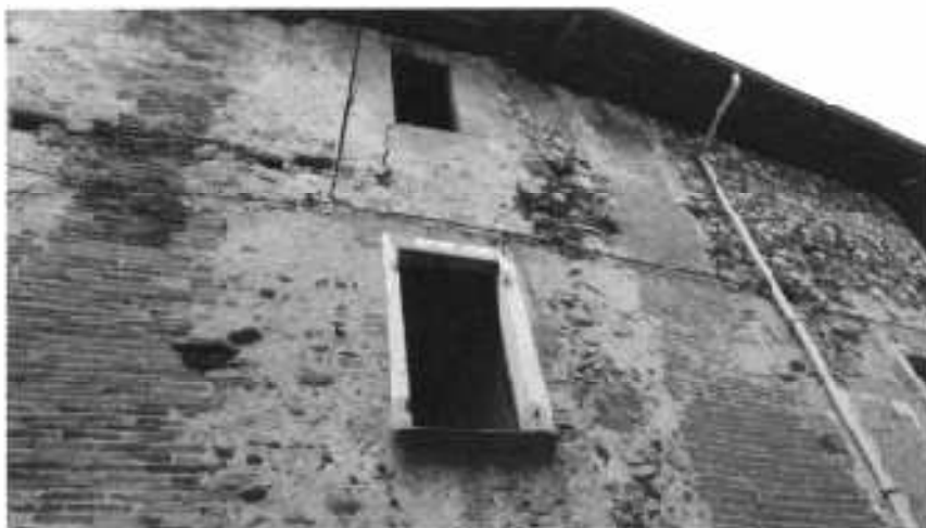
Foto n.1 Facciata esterna dell'edificio su Vicolo San Lorenzo
