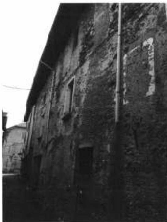
Foto n.2 Facciata esterna dell'edificio su Vicolo San Lorenzo
