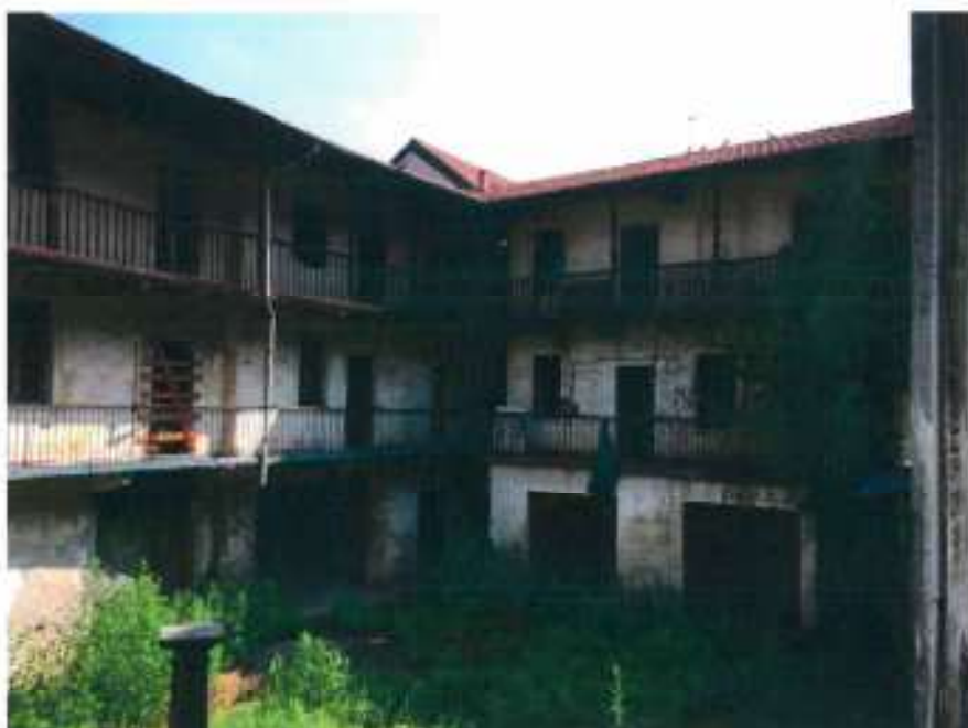
Foto n.4 Facciata interna dell'edificio
