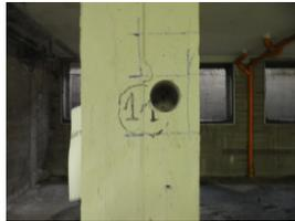
Estrazione di carote di c.l.s. per prove di laboratorio
