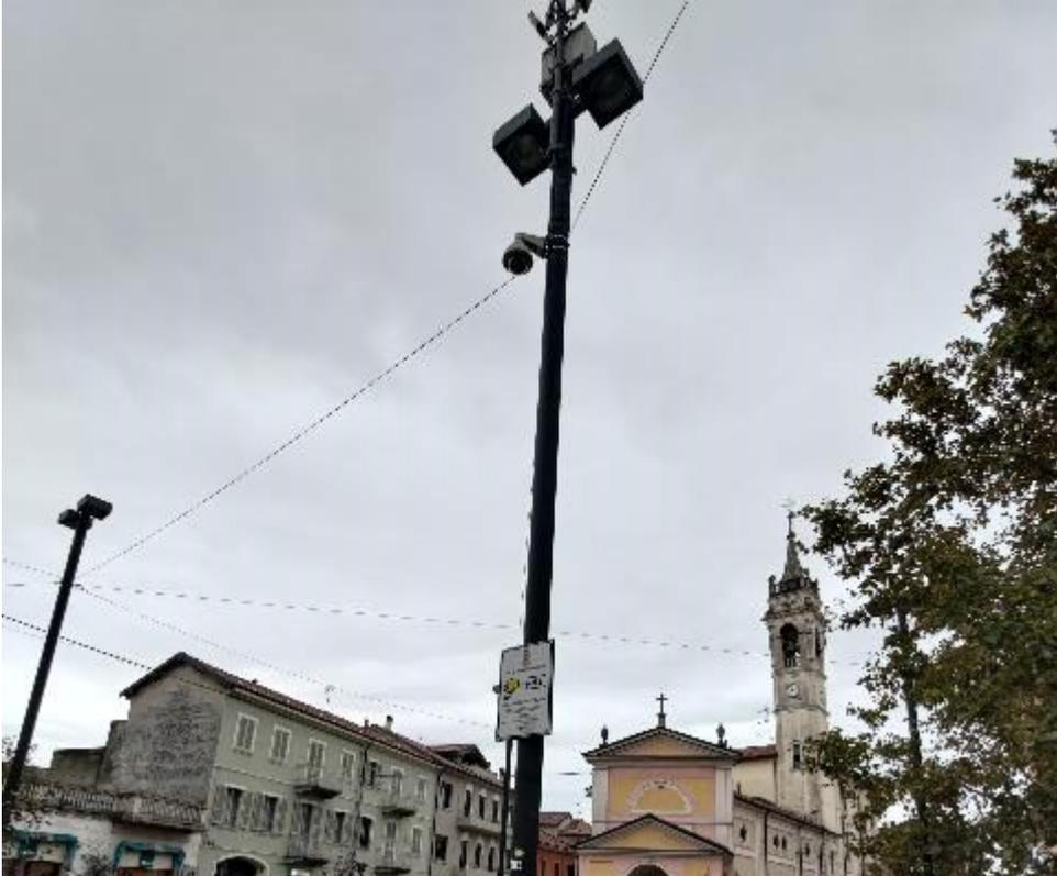
Sostituzione di una vecchia H3 Multisensor con 4 ottiche 12W-H3-4MH-DP1-B con una H5 Multisensor con 4 ottiche 20C-H5A-4MH, il punto di ripresa deve essere spostato più in basso.
