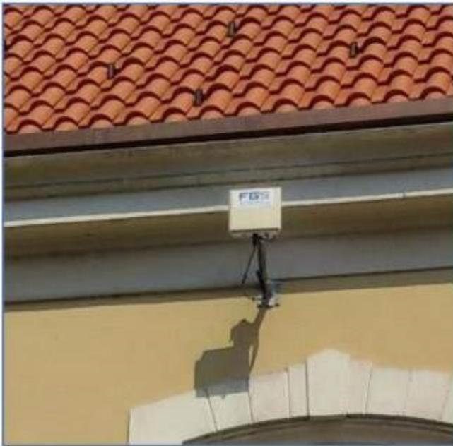
Sostituzione Vecchio ponte radio Mikrotik con il Mikrotik CubeG-5ac60aypair verso Parco della Resistenza previa verifica visibilità altrimenti verso il puntamento attuale al Campanile di Borgomanero.
