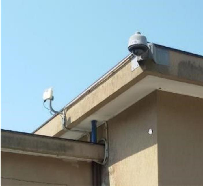
Sostituzione di un vecchia telecamera IP Pelco con una H5 Multisensor con 3 ottiche 15C-H5A-3MH, cavo di rete e supporto ad angolo già presente. Sostituzione di un vecchio ponte radio Mikrotik con il Mikrotik CubeG-5ac60aypair che punta verso il Campanile di Vergano.
