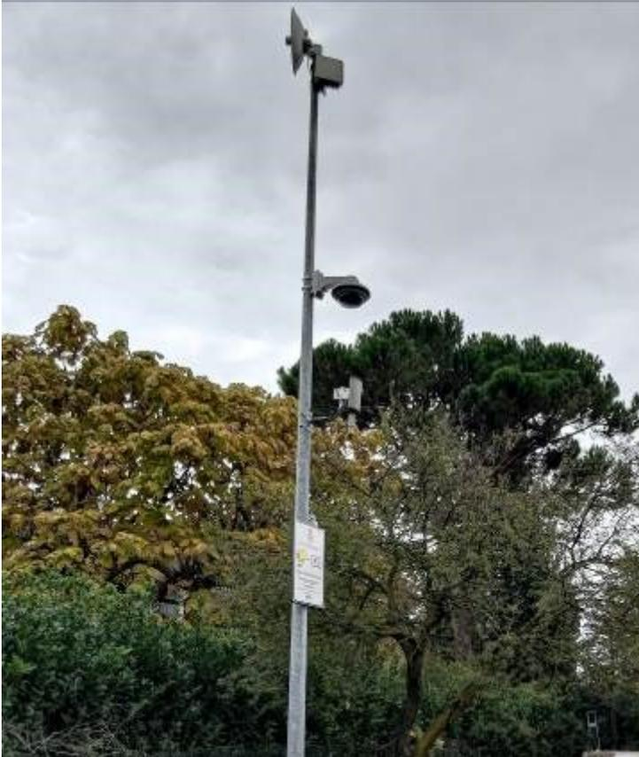
Installazione ponte radio Mikrotik CubeG-5ac60aypair verso Villa Zanetta previa verifica visibilità cavo di rete già a palo altrimenti su Campanile di Borgomanero in sostituzione di un'altra antenna.
