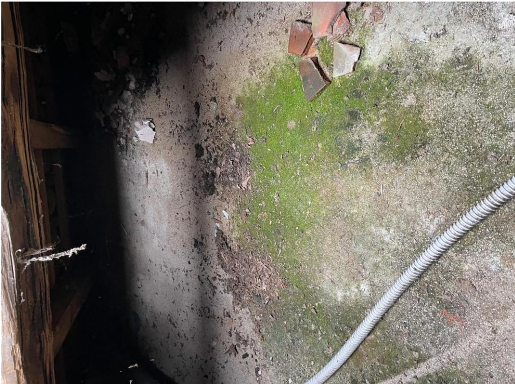
Foto 22: sottotetto copertura ala sud-est. Muschi sull'estradosso del solaio causati da infiltrazioni in copertura
