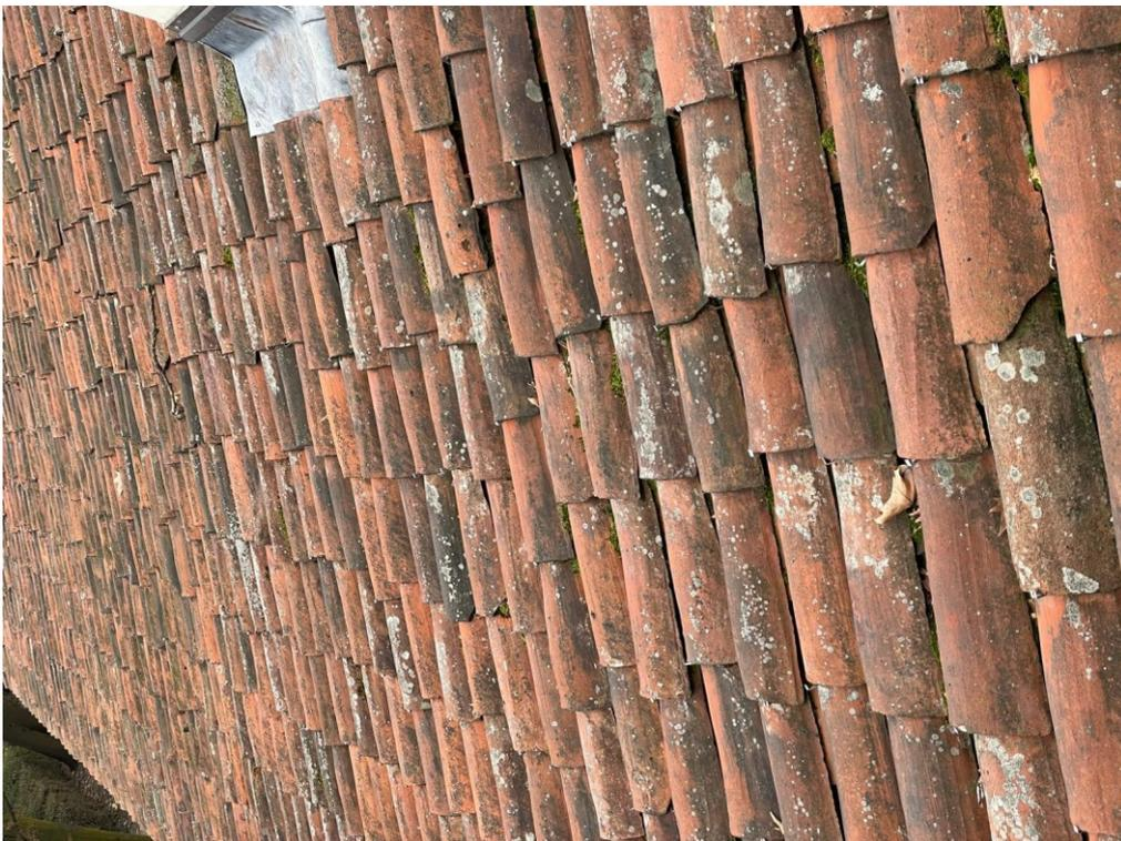
Foto 18: copertura ala sud-est. Coppi rotti senza legature e ganci di fissaggio
