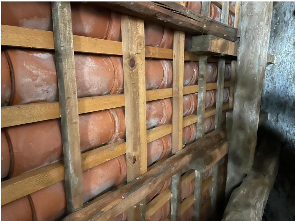
Foto 20: sottotetto copertura ala sud-est, listellatura alla piemontese e efflorescenze da infiltrazioni
