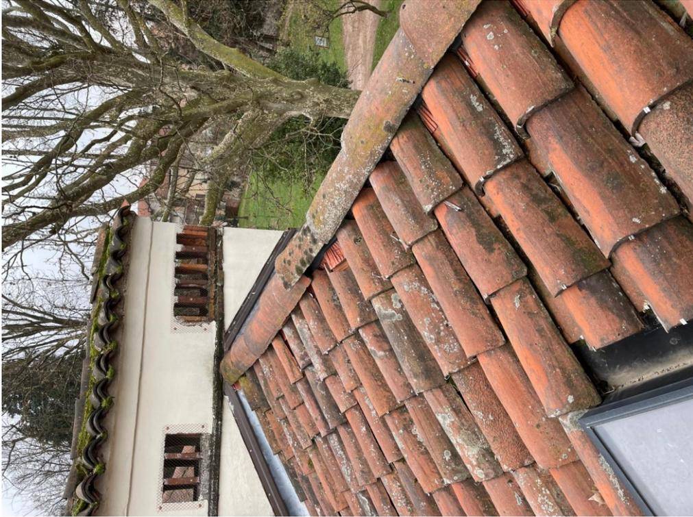
Foto 13: copertura ala sud-ovest. Particolare colmo con guaina erroneamente sotto coppo ed elementi rotti
