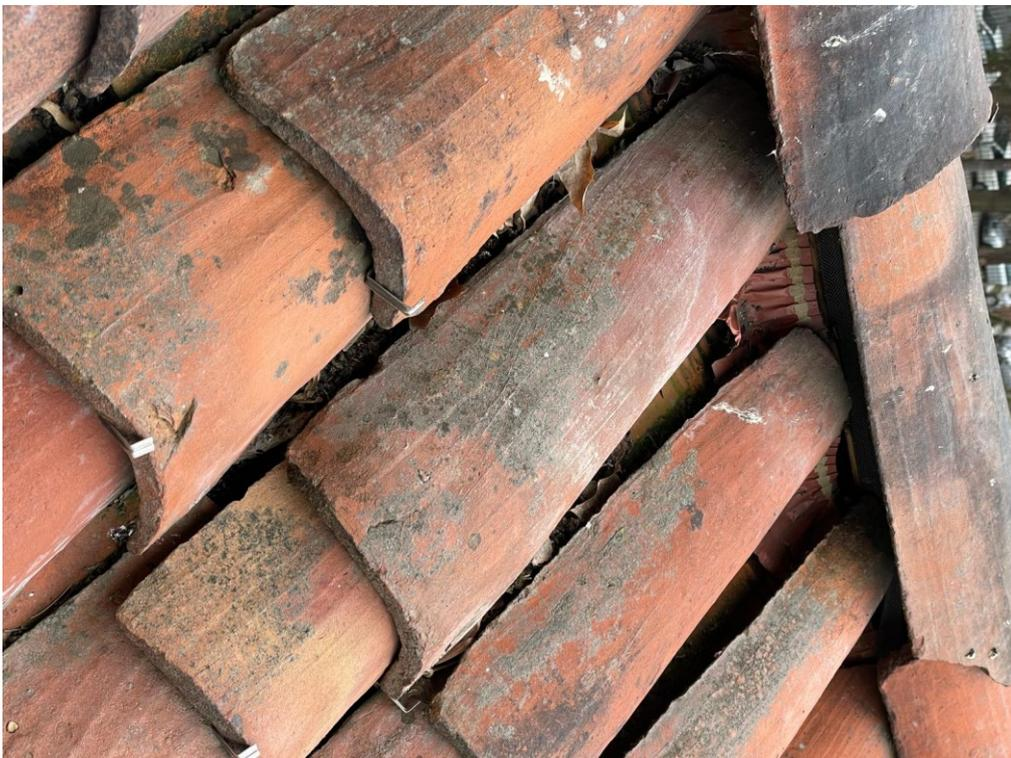
Foto 16: copertura ala sud-est. Particolare guaina sotto coppo, causa di infiltrazioni
